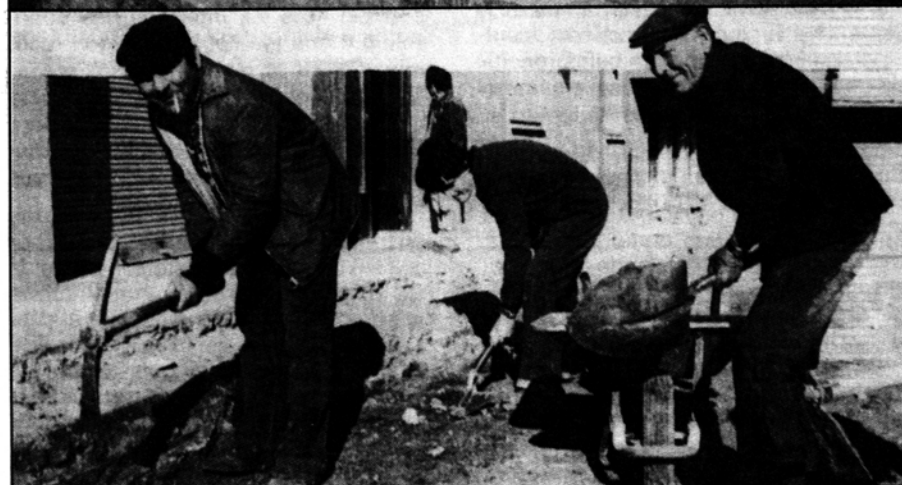
La construcción de un nuevo puente dará trabajo a parados de Mollet (Fotos Archivo).
