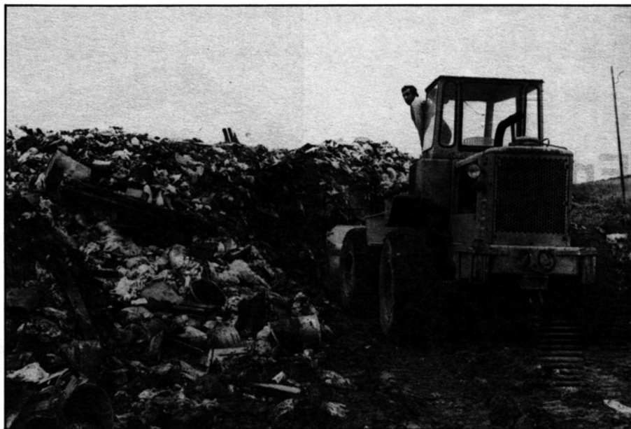
S'està treballant en l'eliminació de l'abocador d'escombraries (Foto Comas).
