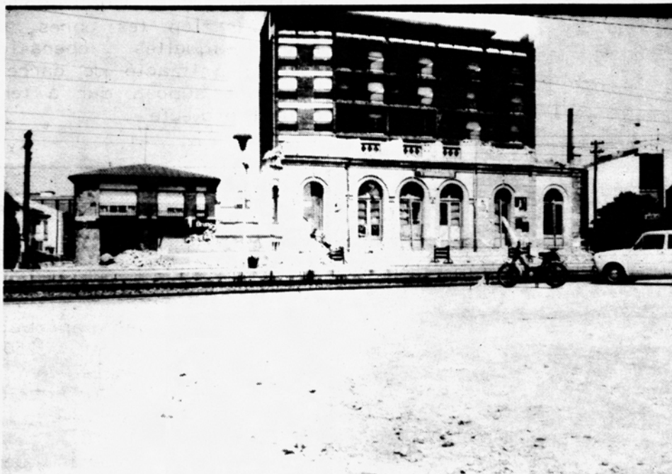
Enderrocament de l'Estació de França Agosto 1.980. Foto: Jordi A. del Rio
