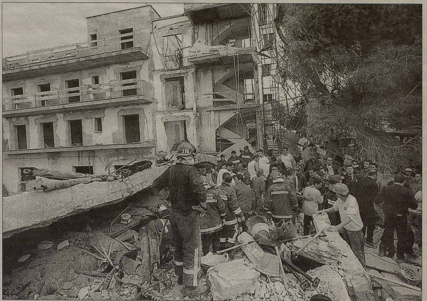
Bomberos y voluntarios, durante los trabajos para el rescate de las víctimas del desplome del hotel Tivoli. / TOLO RAMÓN
